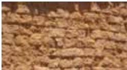
Adobes (brique de terre moulée, forme rectangulaire)
