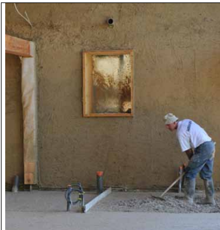
Pose de la chape isolante chaux-chanvre intérieure (épaisseur 18 cm) par un maçon conventionnel. Elle sera recouverte d'une chape de pose et de carreaux de terre cuite pour ajouter de l'inertie dans le bâtiment. Cadre bois flottant prêt à accueillir les menuiseries en bois (mélèze).
