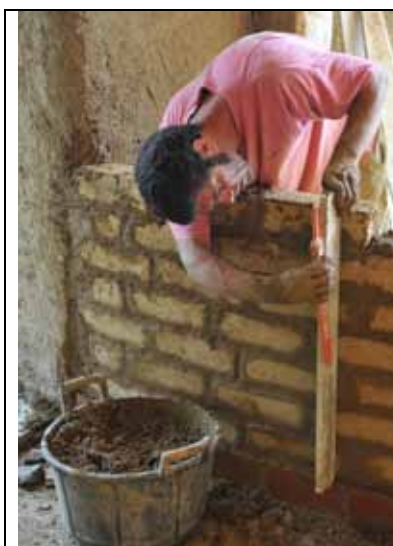
direct à du solaire thermique (ép. 60 cm et Pose des adobes pour des cloisons courbes intérieures (adobes fabriquées par l'artisan)
