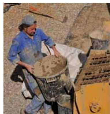
Réalisation des enduits
