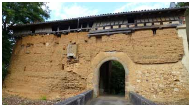
Façade ouest - Rempart en terre massive avec la porte
