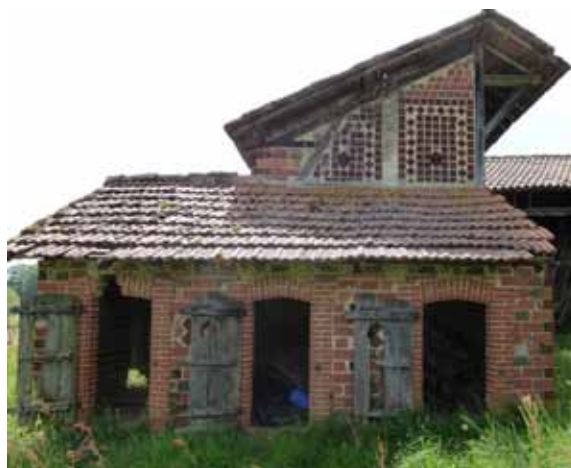
Pigeonnier vu depuis l'est
