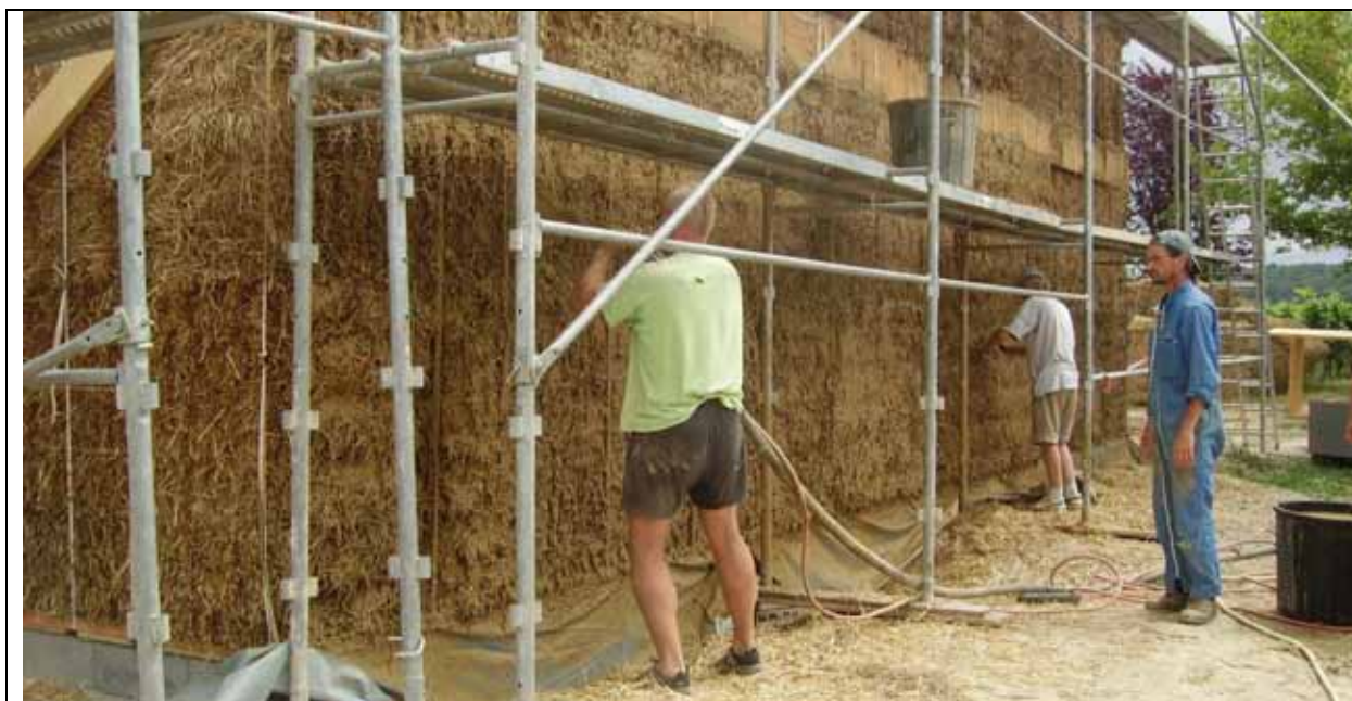
Pose du gobetis extérieur (projeté à la machine) sur les grosses bottes de paille. Préparation pour recevoir la couche de corps de l'enduit terre puis l'enduit de finition à la chaux aérienne en pâte.
