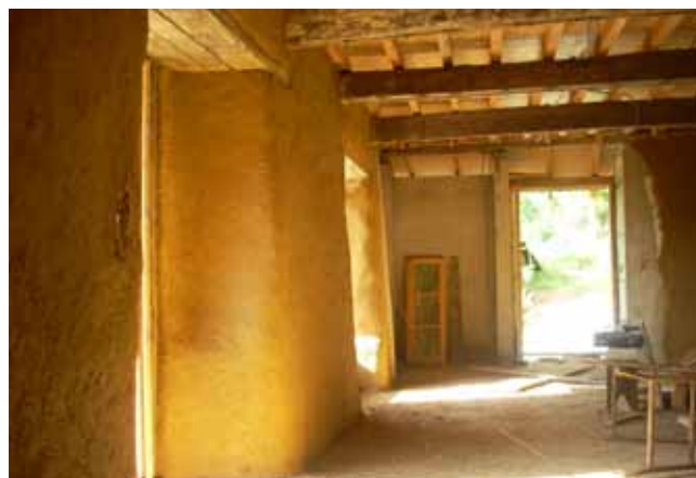
Enduit terre intérieur sur les murs en terre massive
