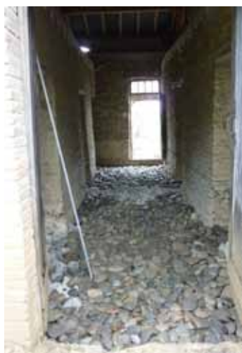
Vue intérieure : murs en adobes sur soubassement en pierres
