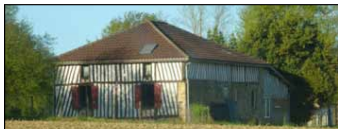
Maison d'habitation en torchis avec mur nord en pierre près de Riscle (32)
