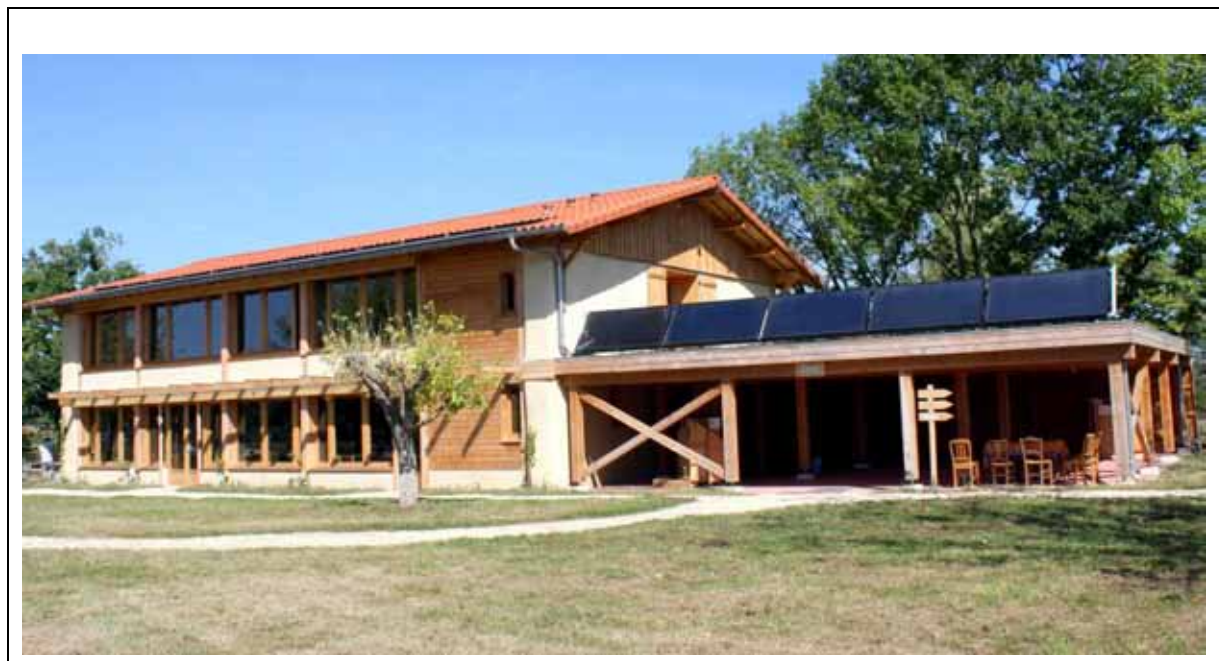
Vue sud-sud/est de l'écocentre : la matériauthèque et sa toiture végétalisée accessible avec les panneaux thermiques solaires. La façade sud entièrement vitrée (protection avec volets roulants en bois extérieurs).
