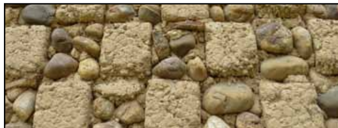
Damier adobes et galets d'un bâtiment à Castelnau Magnoac (65)
