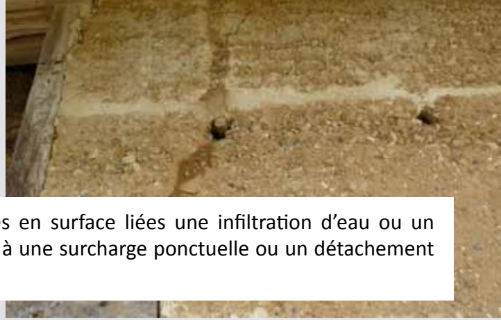
Exemple d'une fissure rebouchée sur une grange à Paladru (38)
