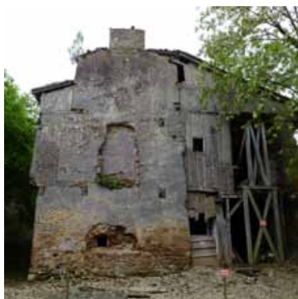
Mur nord recouvert d'un enduit ciment
