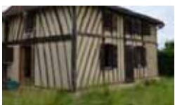
Torchis (terre/paille dans une ossature bois)
