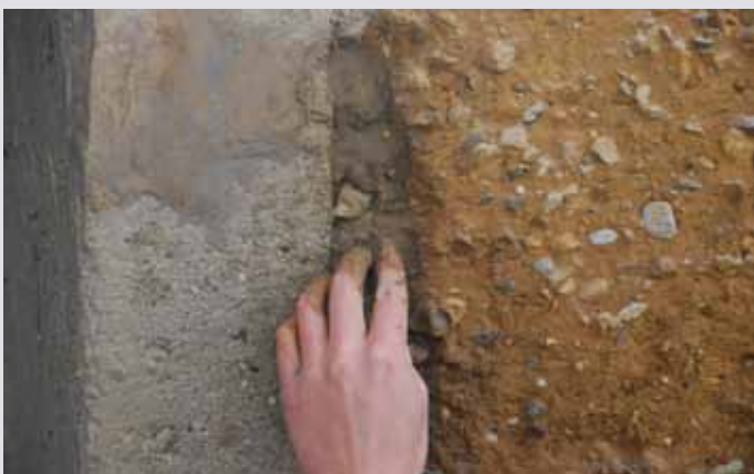
Exemple de rebouchage d'une mini-fissure comblée avec de la terre tassée à la main.
