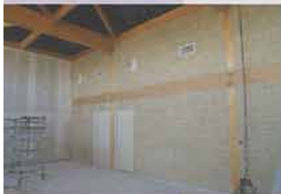
Cloisons en briques de terre crue (BTC) de l'école de Saint-Germé.
