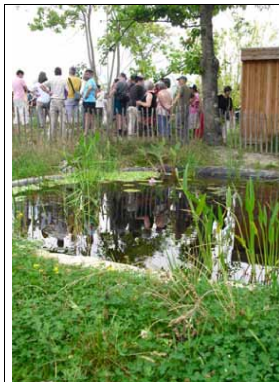
L'épuration des eaux usées est réalisée par des filtres plantés. L'eau rejetée épurée est stockée dans la mare vivante (qui récupère aussi les eaux du trop plein des cuves d'eau de pluie). Le site est entièrement et seulement équipé de toilettes sèches.
