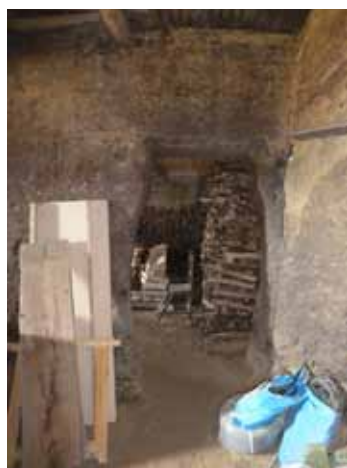
Mur de l'ancien chai en terre massive
