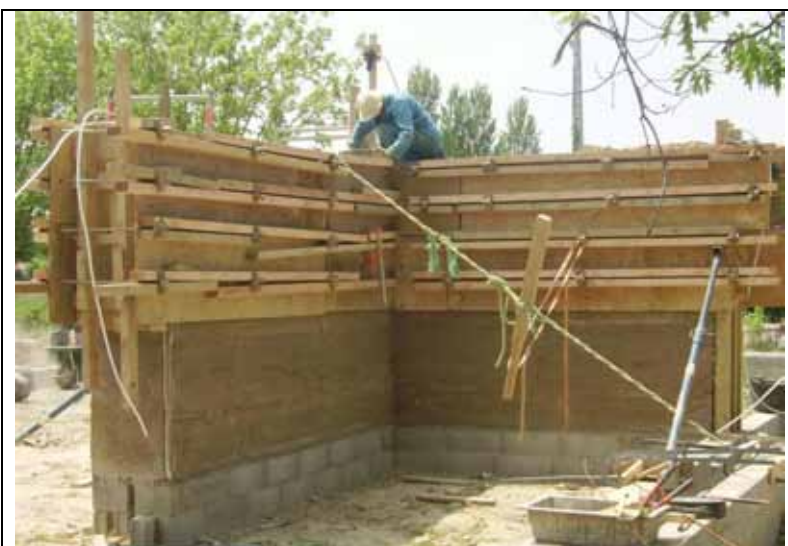
Mur en pisé accumulateur chauffant/ rafraichissant bâti avec la terre des fondations et perçu de tuyau raccordés en hauteur 2 m 85)
