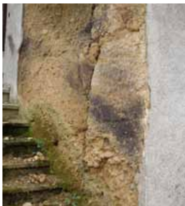
Mur en terre massive
