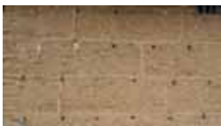
Pisé (terre damée dans un coffrage, présente de strates et de trous)
